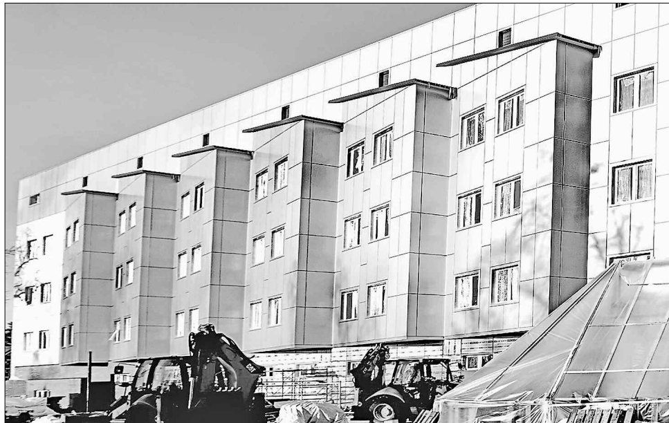
Будівельники роблять останні штрихи на території перинатального центру
