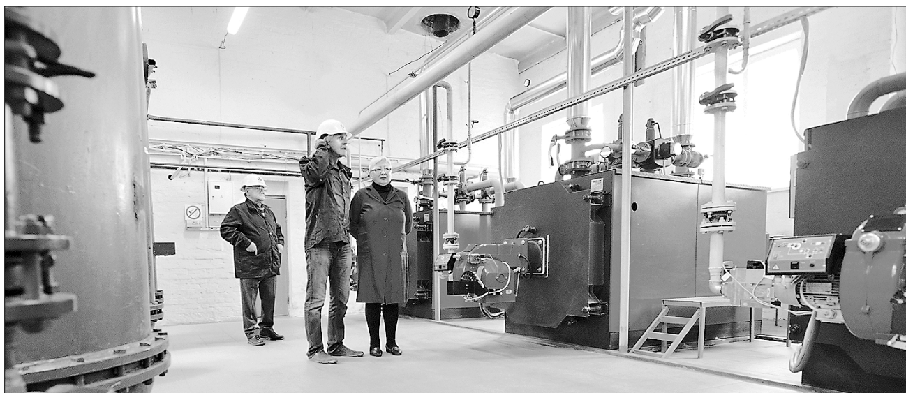
Сумчани замінюють застарілі котли на сучасні енергоефективні
