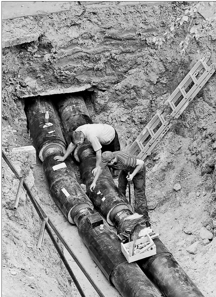
Ці труби гріють землю, а не квартири
