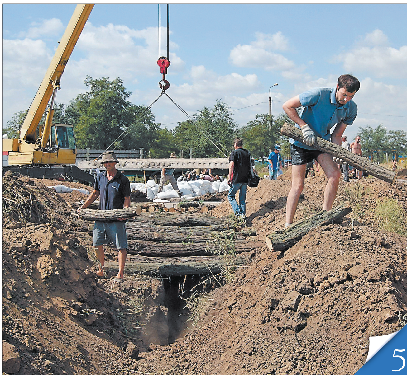
Довкола міста пришвидшеними темпами зводять оборонні споруди
