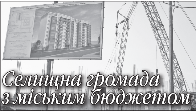
Початок будівництва спорткомплексу та житлового будинку. Літо 2017 року
