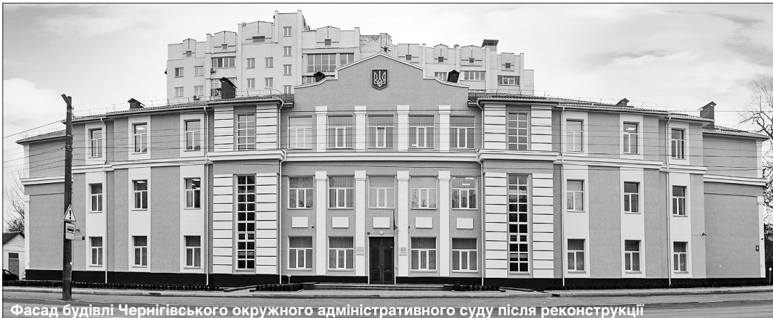
Фасад будівлі Чернігівського окружного адміністративного суду після реконструкції
