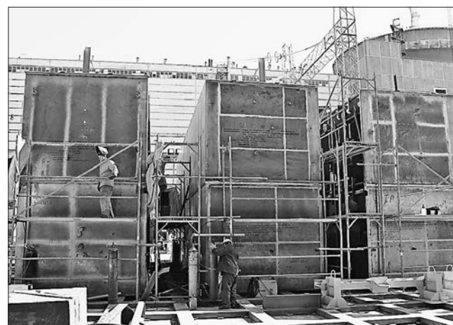
Підготовка до монтажу нового блочно-модульного конденсатора на енергоблоці найбільшої атомної станції Європи — Запорізької АЕС
