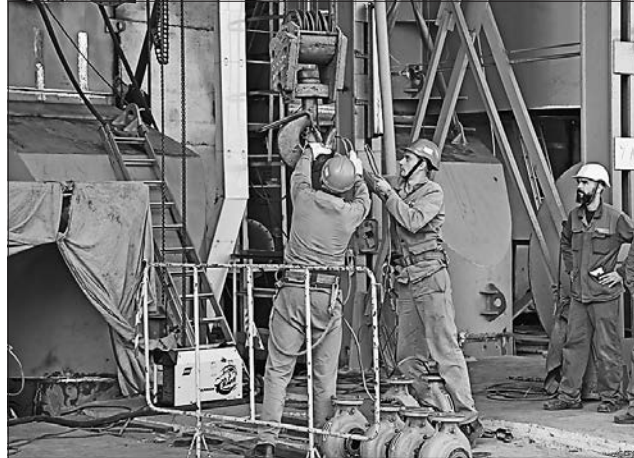
Процес заміни конденсатора потребує величезного обсягу монтажних і зварювальних робіт
