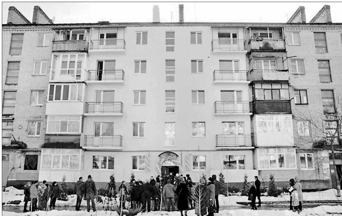
Відновлений після закінчення бойових дій будинок на вулиці Бульварній, 4 справив друге новосілля
