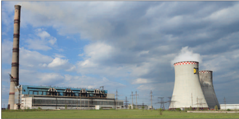
На Зуївській ТЕС ТОВ «Східенерго» виконано роботи з модернізації енергоблока №1
