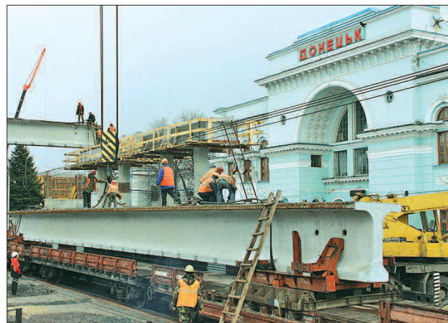
Станція «Донецьк» набуває сучасного вигляду
