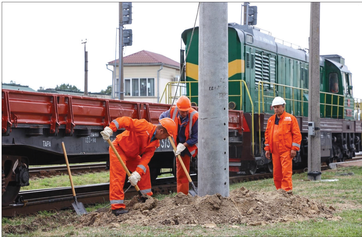
На ділянці від Черкас до Сміли встановлено вже 126 електроопор з необхідних 800. Решту встановлять протягом двох місяців
