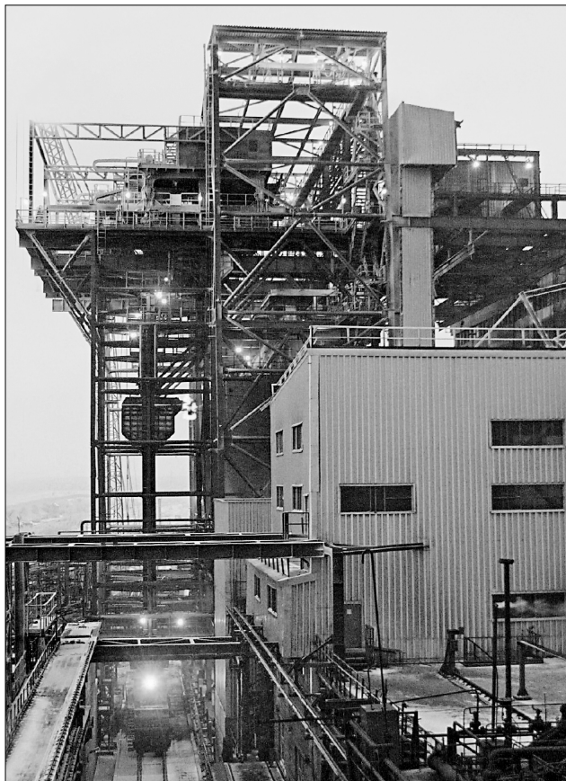
Понад 20 харківських установок сухого гасіння коксу експлуатують у країнах близького (СНД) і ще 16 — далекого зарубіжжя
