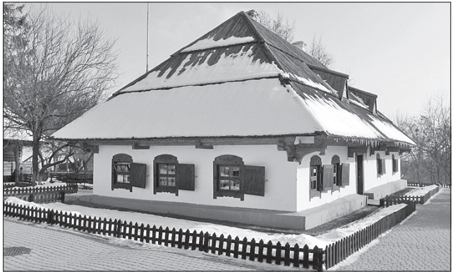
Найбільше коштів знадобиться на ремонт покрівлі садиби
