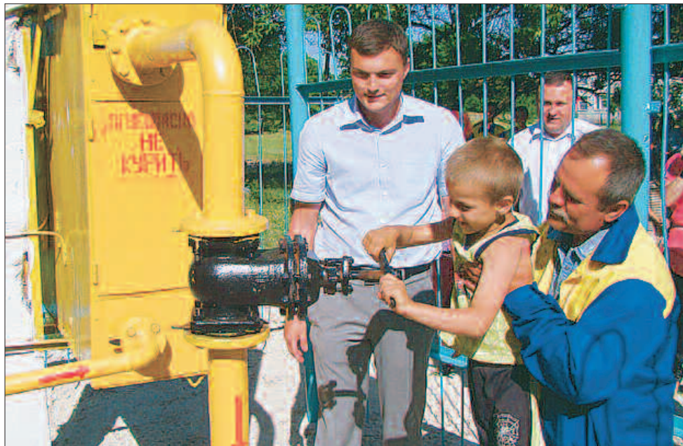
Знакова для села подія — підключення розвідного газопроводу
