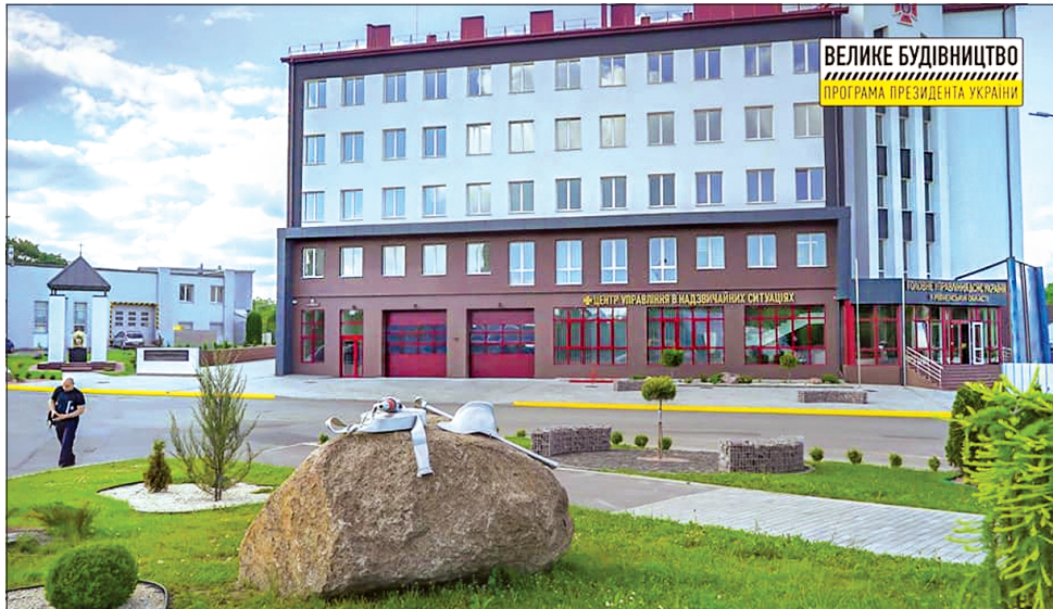
Ще один об'єкт «Великого будівництва» у Рівному — пожежне депо, яке об'єднує пожежну частину, кризовий центр та 44 квартири для пожежників і рятувальників
