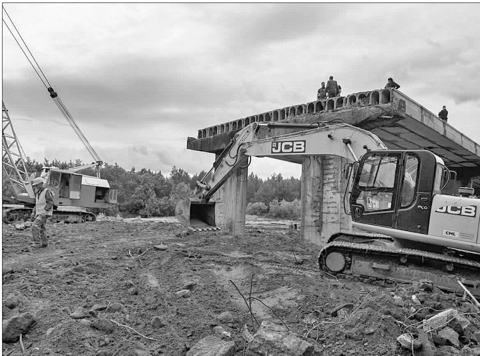
Повним ходом триває будівництво мосту поблизу села Бішкін
