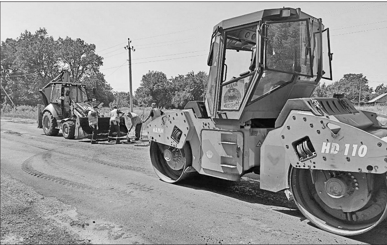
Дорожники поспішають відремонтувати якомога більше доріг, доки є кошти і будівельні матеріали
