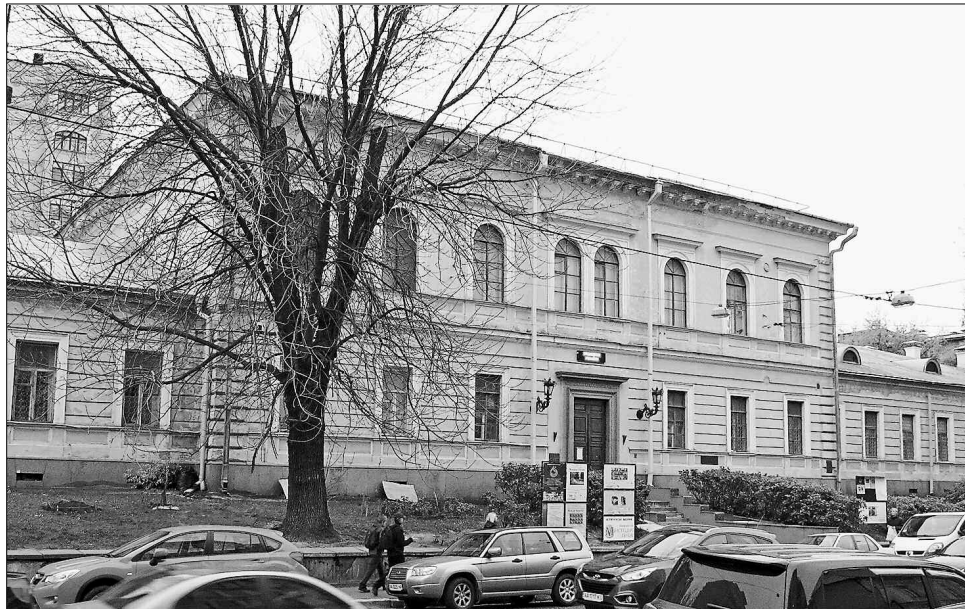
Будинок не має фундаменту, але до нашого часу не знав капітального ремонту
