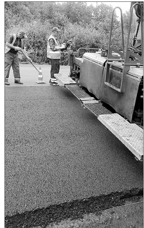
Фахівці зазначають, що якість ремонту висока
