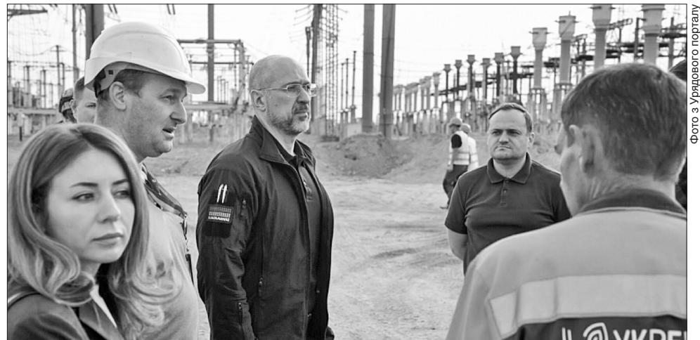
Денис Шмигаль разом з урядовцями оглянув хід будівництва інженерного захисту на енергопідстанціях
