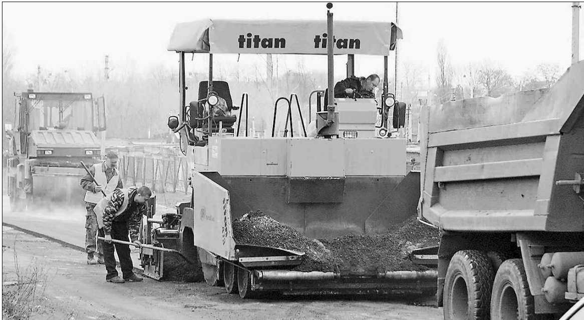
Обласні дороги ремонтують постійно, а не в авральному порядку
