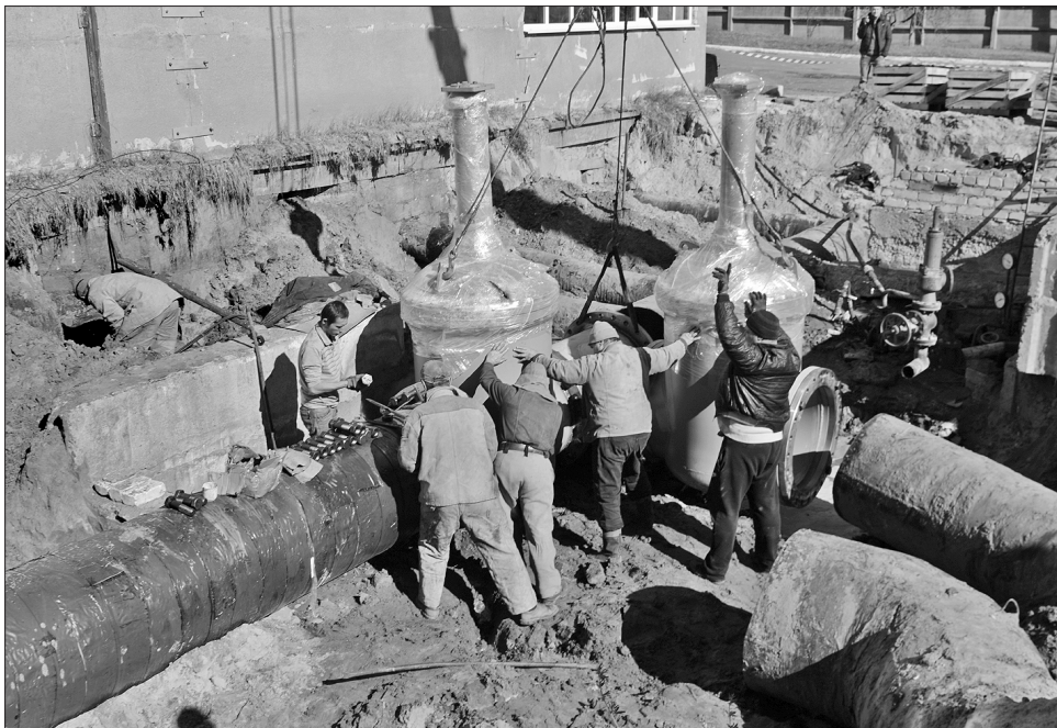
На Петрівській насосній станції виконано великий обсяг робіт
