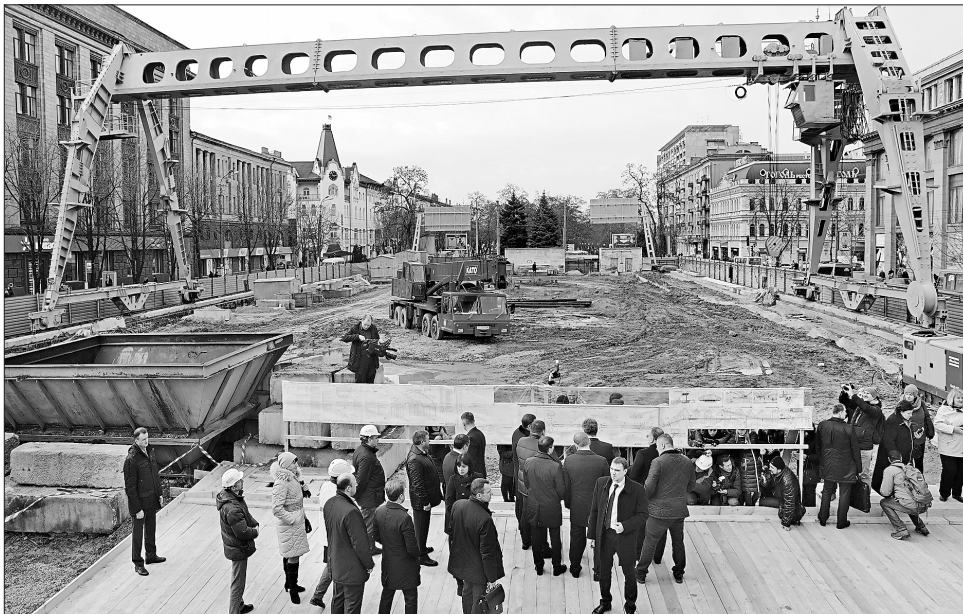
На будмайданчику станції «Центральна» роботи не припиняються
