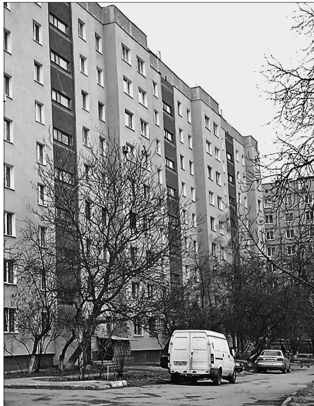
Після утеплення на будинок любо подивитися
