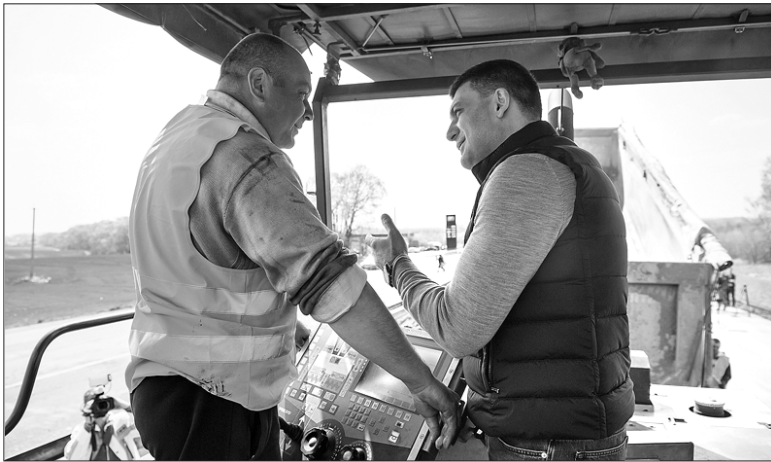
Майже в кожному районі тривають дорожні роботи, виходить техніка
