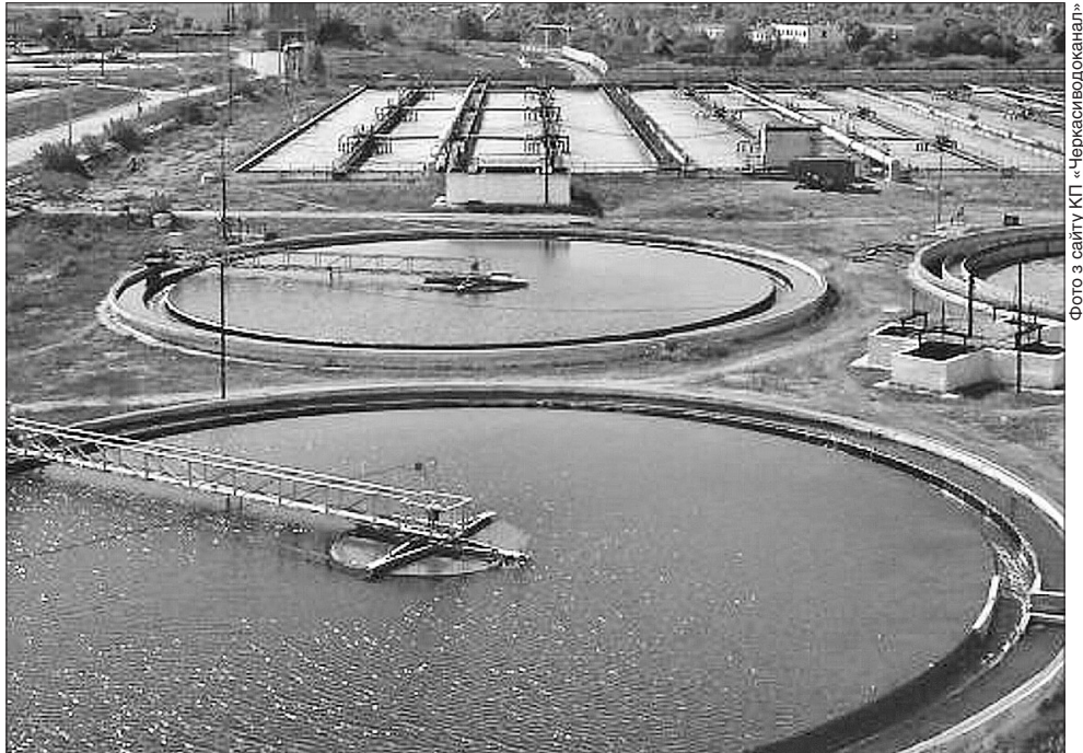
Фото з сайту КП «Черкаси-водоканал»
