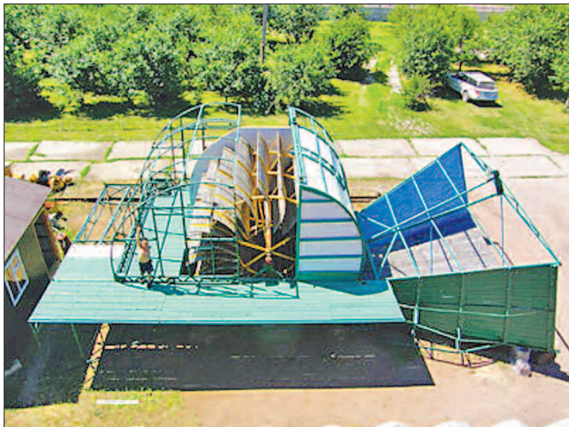
Ось така мініатюрна гідроелектростанція
