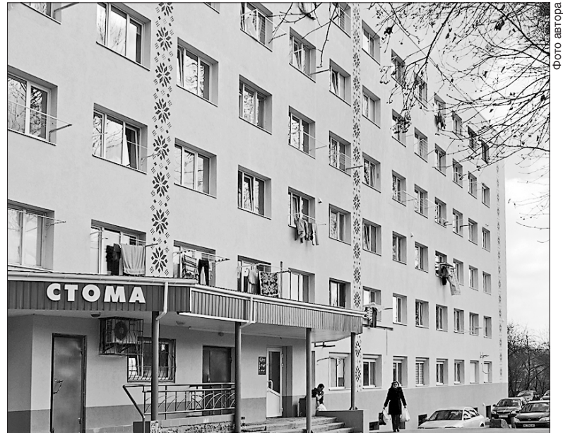
Після проведених робіт — гарний, ошатний дім
